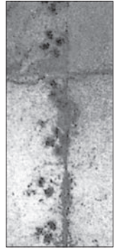
▲鋼製スペーサによる塩害例 やがてサビは主筋におよび、躯体を破壊する。
